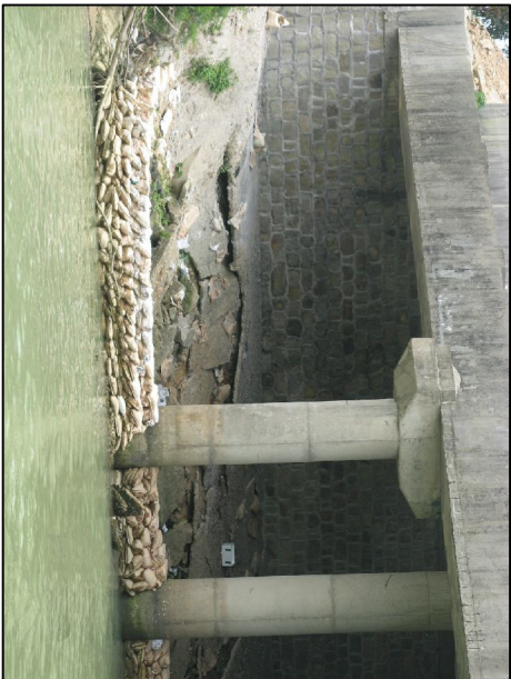
惠来岸护坡破损
